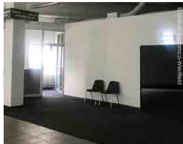
↑ Innenausbau Gropius Passagen (Februar bis März 2021)
