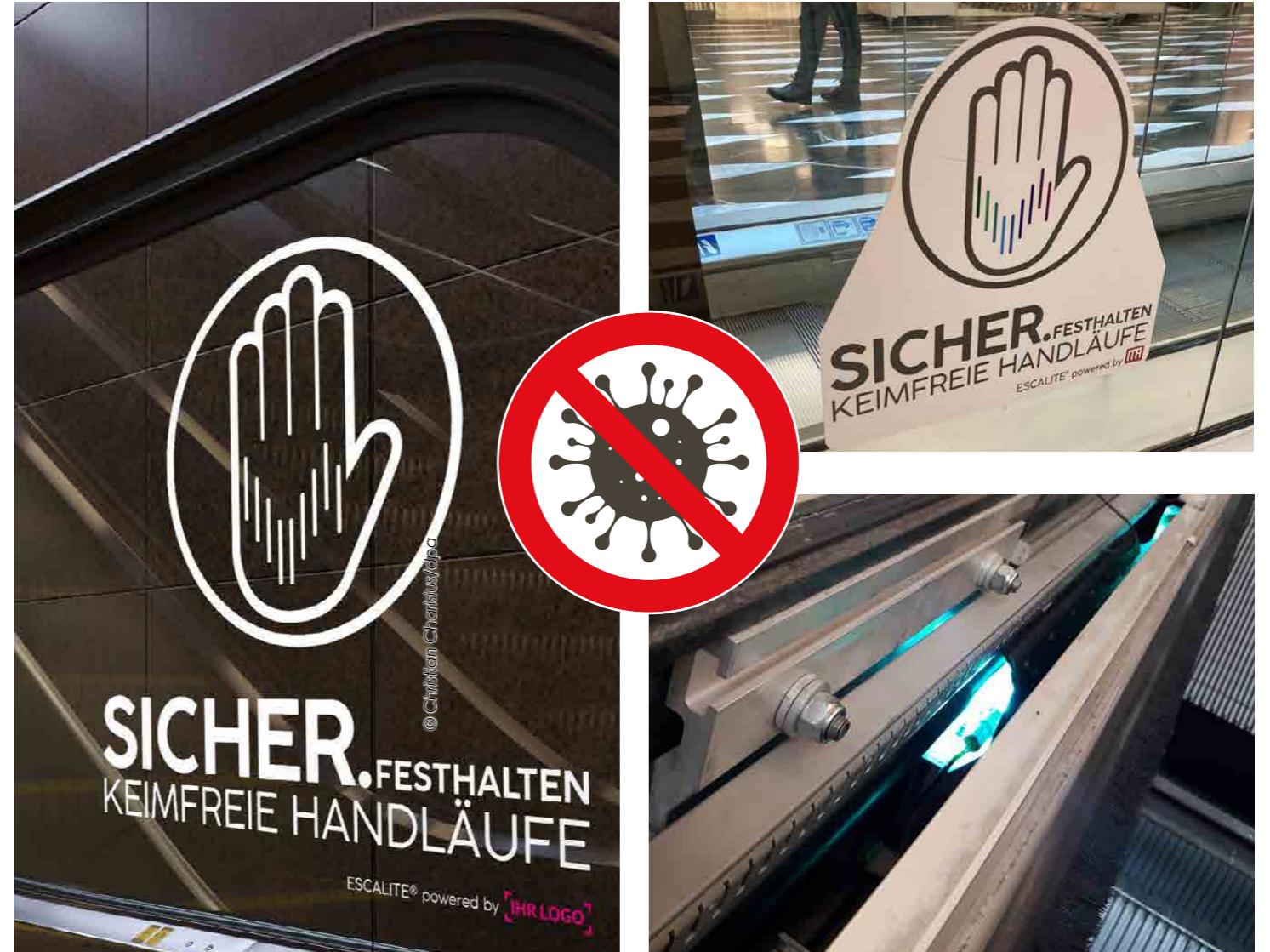
↑ Installation einer innovativen UV-Technik: Keimfreie Handläufe durch physikalische Desinfektion von Halte- und Berührungspunkten (im Bereich der Rolltreppen)
